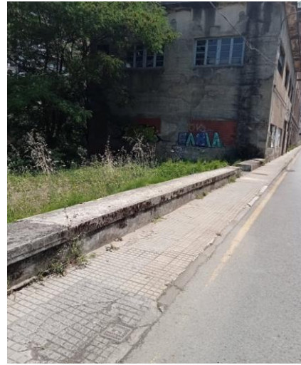
Llave final de tramo
