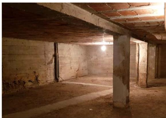
Para resolver esa situación se propone el desvío de las bajantes de fecales una vez atravesado el forjado de la planta cero y la instalación de un colector suspendido que, a través de una perforación del muro del sótano, conecte con las arquetas de acometida incluidas en proyecto.
