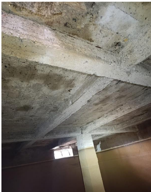
Ilustración 3. Interior depósito a reparar
