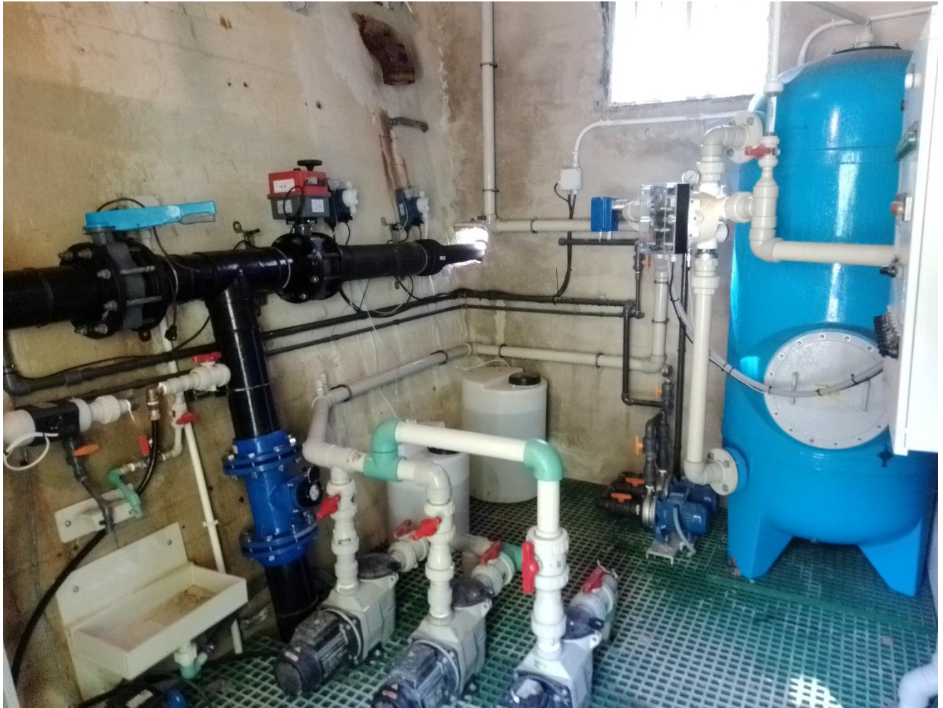
Ilustración 13. Estado actual de la cámara de llaves de Igaran
