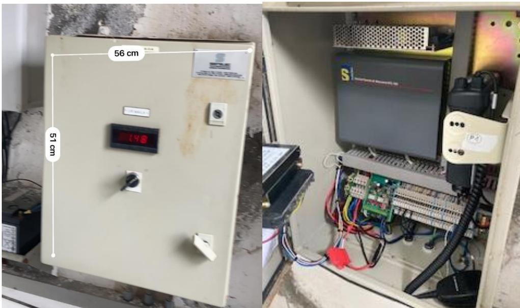
Ilustración 2. Modelo y dimensiones de armarios de comunicaciones en Ataun.
