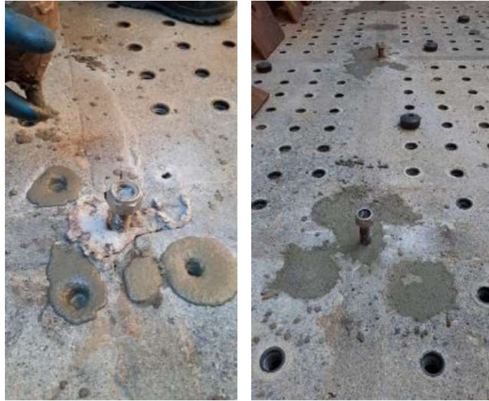
Imagen 2. Reparación de placas de pilares sin placas retiradas
