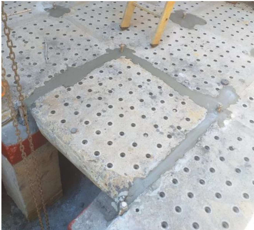
Imagen 3. Reparación de juntas entre placas
