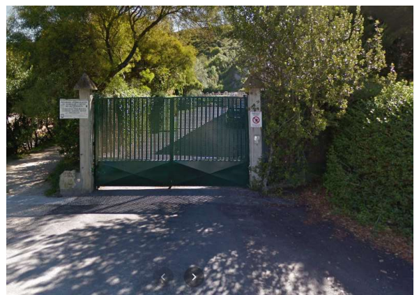
Ilustración 2. Entrada a la EDAR de Iñurritza.
