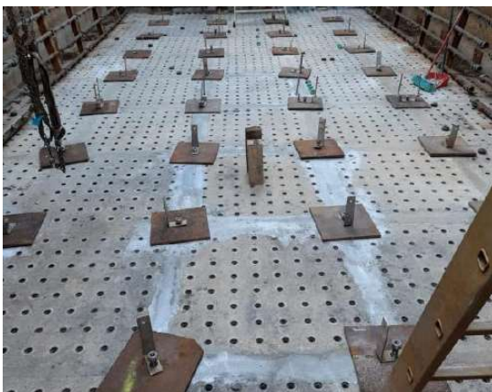
Ilustración 8. Placas de falso fondo con planchas de anclaje
