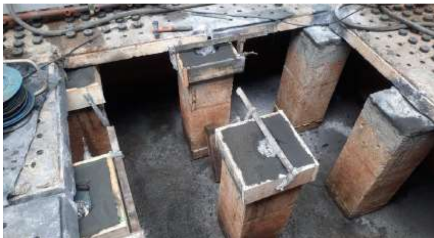
Imagen 1. Reparación de cabezas de pilares con placas retiradas
