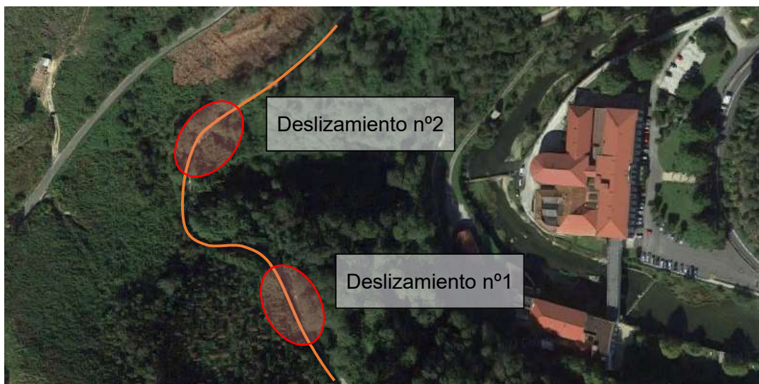
Ilustración 2. Situación de los deslizamientos ocurridos en el camino.
