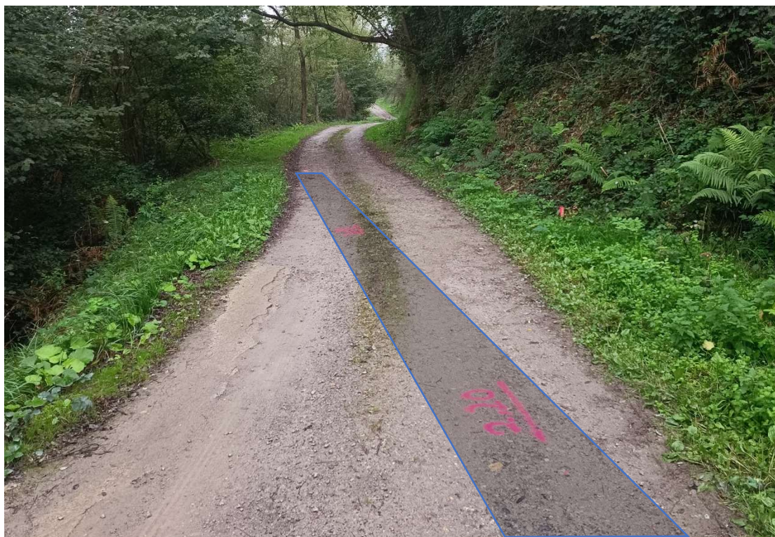
Ilustración 5. Localización aproximada de la zanja que aloja el tubo de abastecimiento y cota obtenida en sondeo en la zona del primer deslizamiento.
