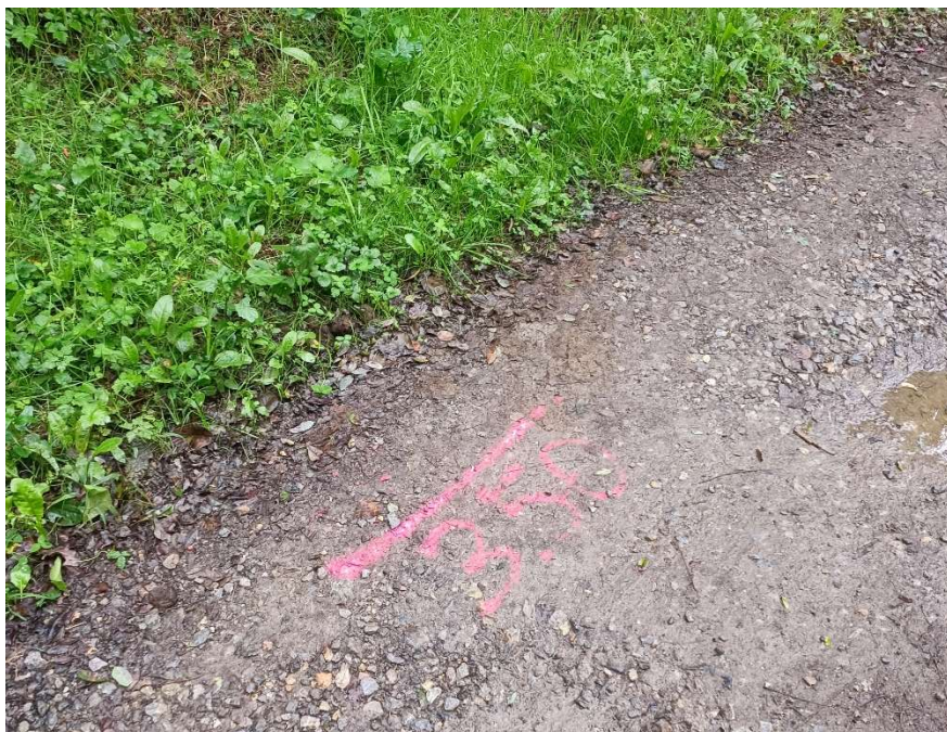
Ilustración 6. Cota aproximada del fondo de la conducción en la zona del segundo deslizamiento.
