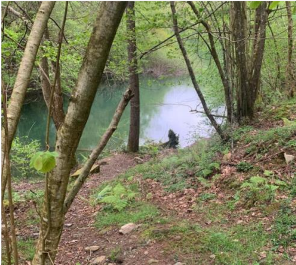
Punto de salida del cable. Paso de sumergido a enterrado por terreno
