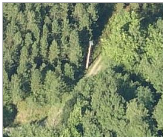
Vista aérea del panel solar sobre poste de hormigón
