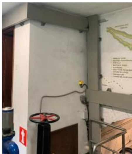
Inicio de la canalización
