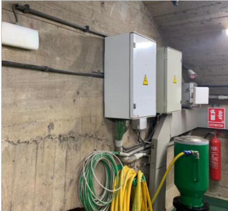
Fin de la galería (sala de las válvulas Bureau)
