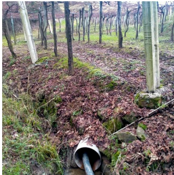
Foto 6: Detalle del entubamiento de la red existente que discurre bajo el viñedo (Fte.: Elaboración propia)
