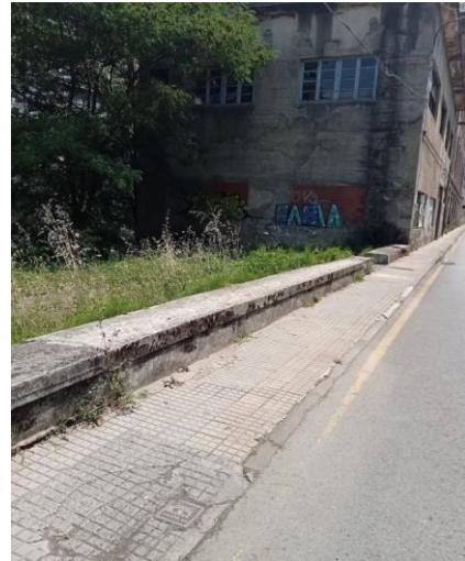
Llave final de tramo
