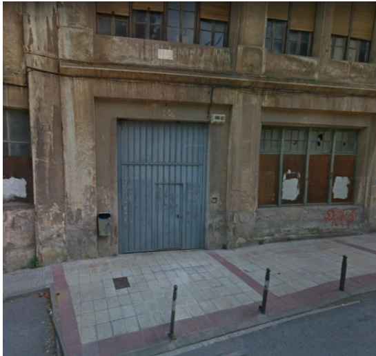
Inicio frente edificio nº21
