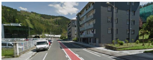
Renovación red Fibrocemento Ø 100 – Zaldibidea.
