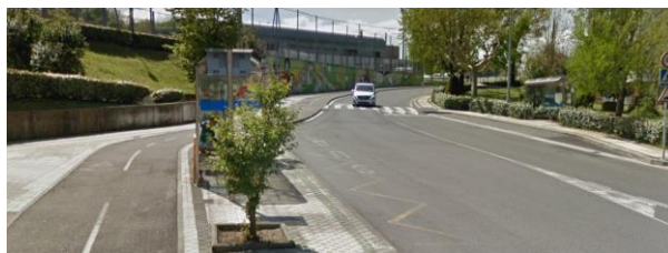
Renovación red Fibrocemento Ø 150 – Gudari etorbidea.
