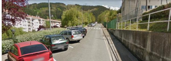
Renovación red Fibrocemento Ø 150 – Majori Plaza.
