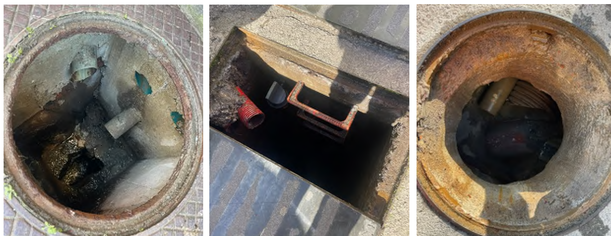
Figura nº 4: Imágenes del levantamiento de arquetas tomadas el 24/02/2025.
