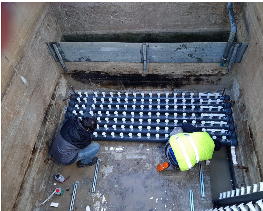
Ilustración 3. Filtro Nº2 durante su reconstrucción.
