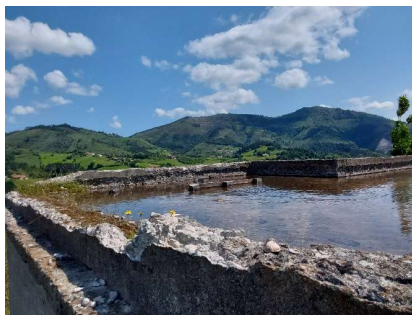
7 - Muros perimetrales en la cubierta superior
