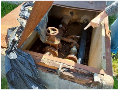
8 - Arqueta en cubierta
