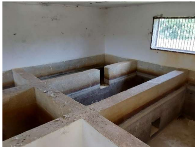
9 - Depósito en zona superior en desuso
