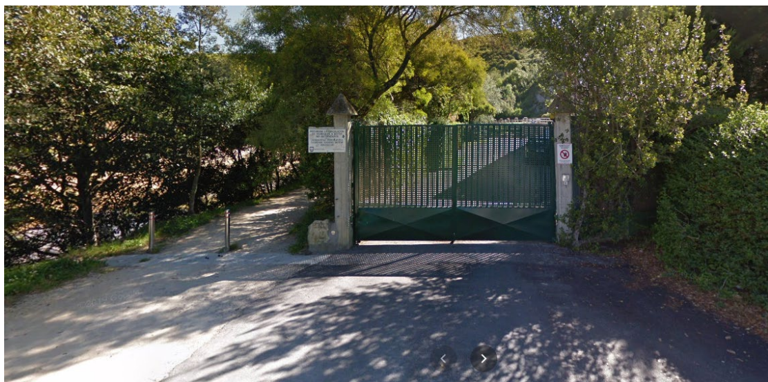
Ilustración 2. Entrada a la EDAR de Iñurritza y senda peatonal hasta túnel del emisario.
