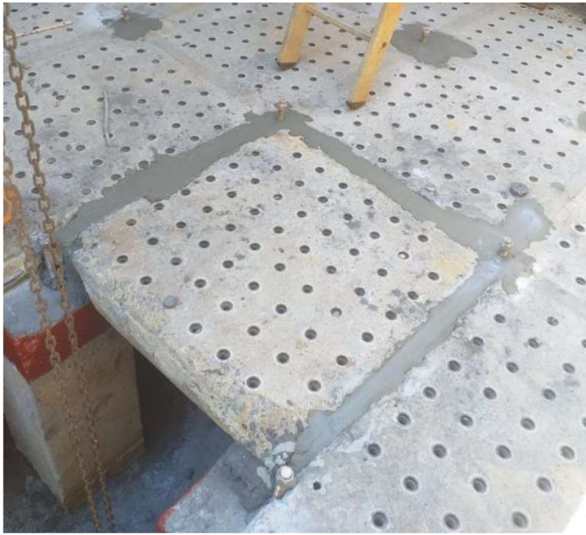
Imagen 3. Reparación de juntas entre placas
