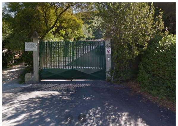
Ilustración 2. Entrada a la EDAR de Iñurritza.
