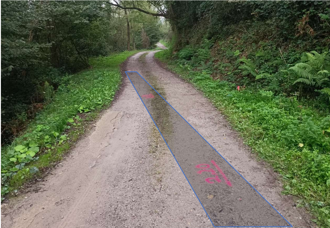
Ilustración 5. Localización aproximada de la zanja que aloja el tubo de abastecimiento y cota obtenida en sondeo en la zona del primer deslizamiento.
