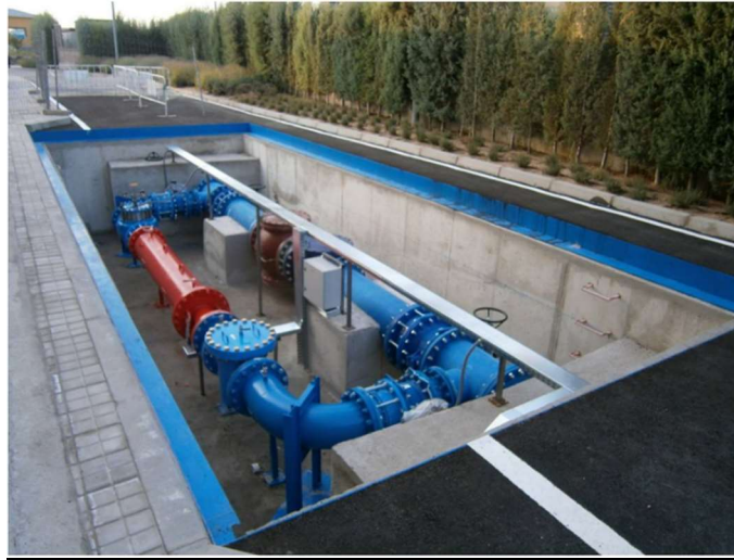
Ilustración 4. Ejemplo de instalación de turbina en arquetón
